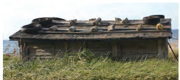
図4-12 柱状節理に沿って割れたデイサイトを小屋の屋根の重石に利用した例
