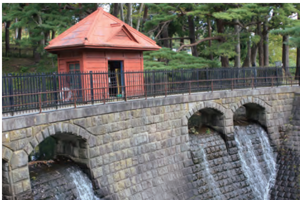
図3-57 釜臥山の安山岩を使っているといわれる「大湊水源地水道施設 沈澄池堰堤」（むつ市水源池公園）
